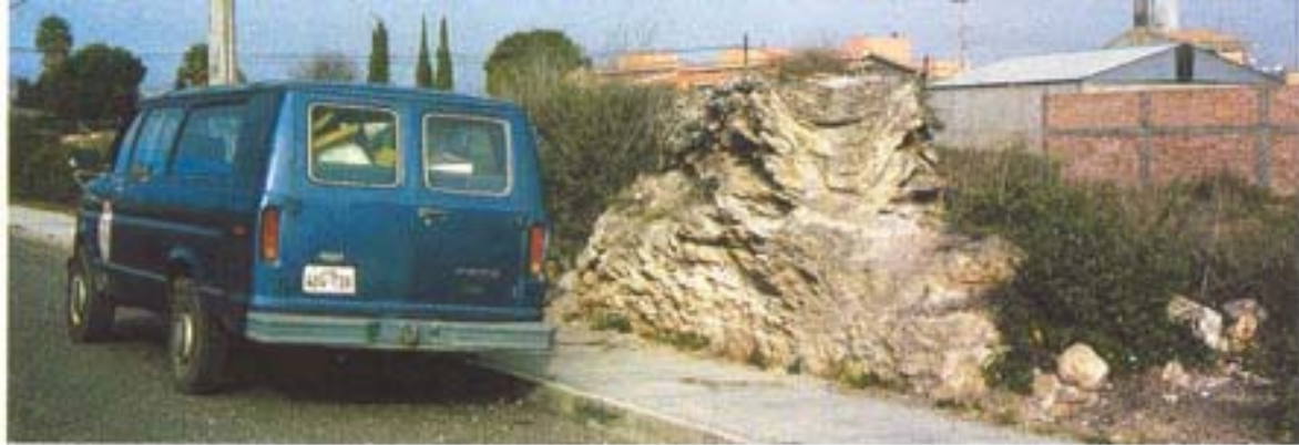
Algunas construcciones modernas han dañado parte del antiguo canal.
